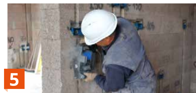
5 Réalisation des saignées avec rainureuse.
