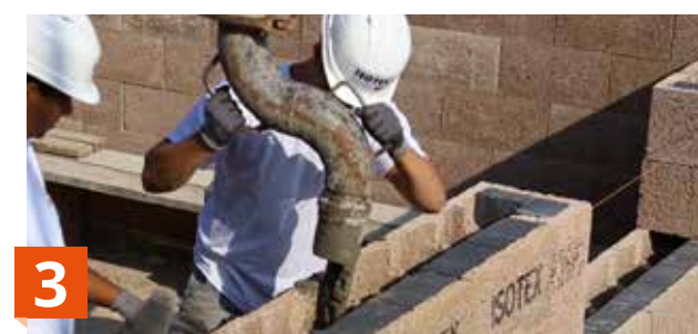
3 Remplissage des blocs avec coulage du béton (toutes les 6 rangées).
