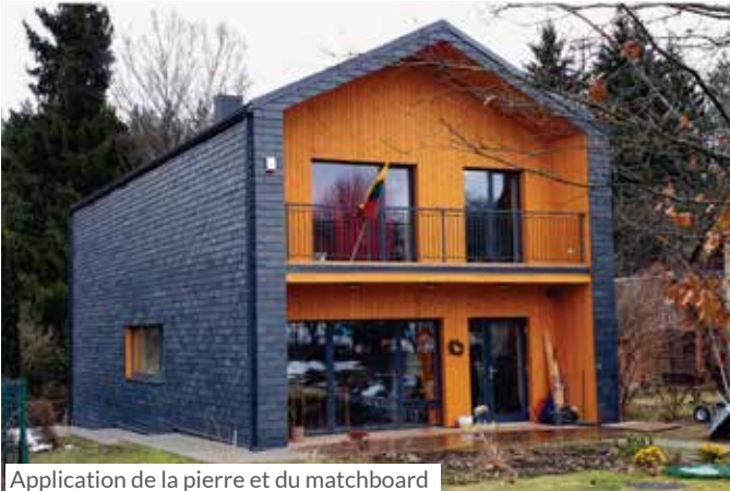
Application de la pierre et du matchboard
