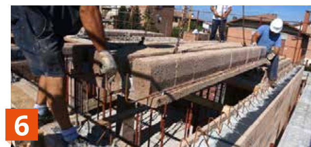
6 Pose des panneaux planchers, calculés et réalisés sur mesure.
