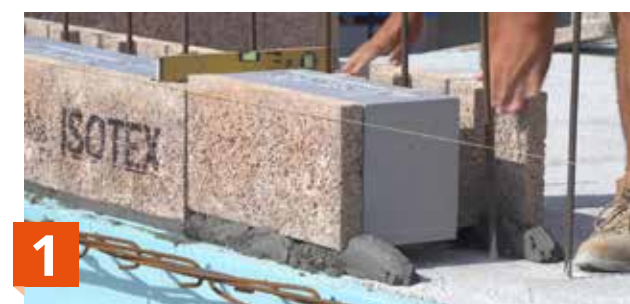
1 Pose de la première rangée avec niveau à bulle pour la mettre à niveau
