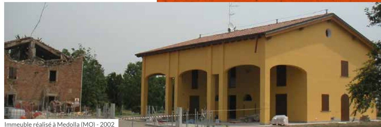
Immeuble réalisé à Medolla (MO) - 2002
