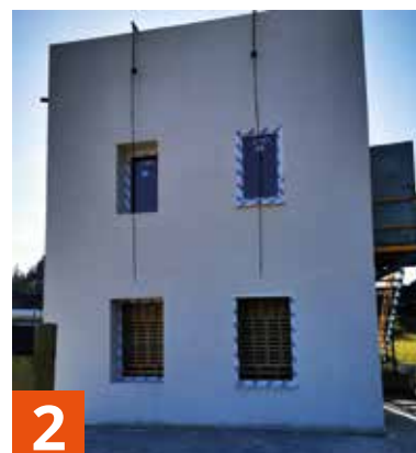
2 Le mur Isotex avait 2 ouvertures au rez-de-chaussée et premier étage plus un voile sans ouvertures en haut.
