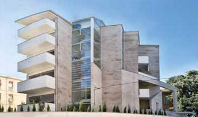
Pose de marbre
