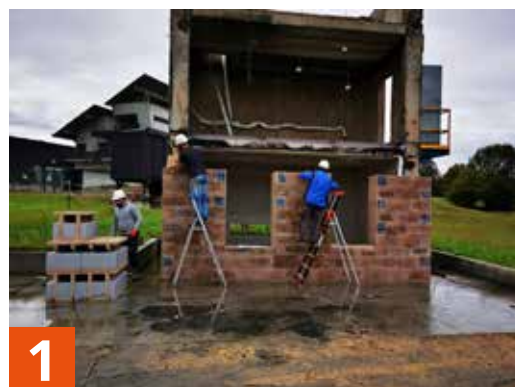
1 Un mur de 5,5x7 mètres a été construit avec bloc 44/23 en graphite Basf Neopor®
