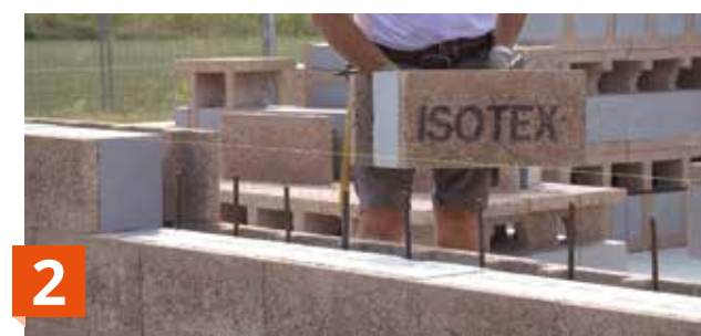
2 Pose des rangs suivants à sec.
