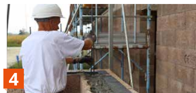
4 Pose des ferrailages verticaux (antisismiques) dans les alvéoles des blocs.
