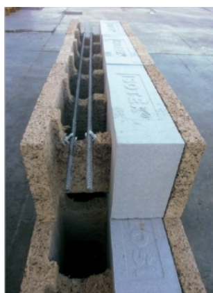
Figure 5 – Mise en œuvre du ferrailage horizontal - double
