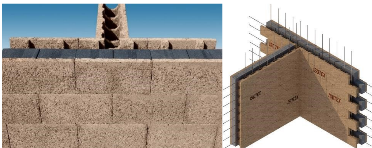
Figure 13 – Exemple de jonction entre murs perpendiculaires
