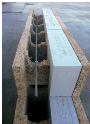
Figure 4 – Mise en œuvre du ferrailage horizontal - individuel
